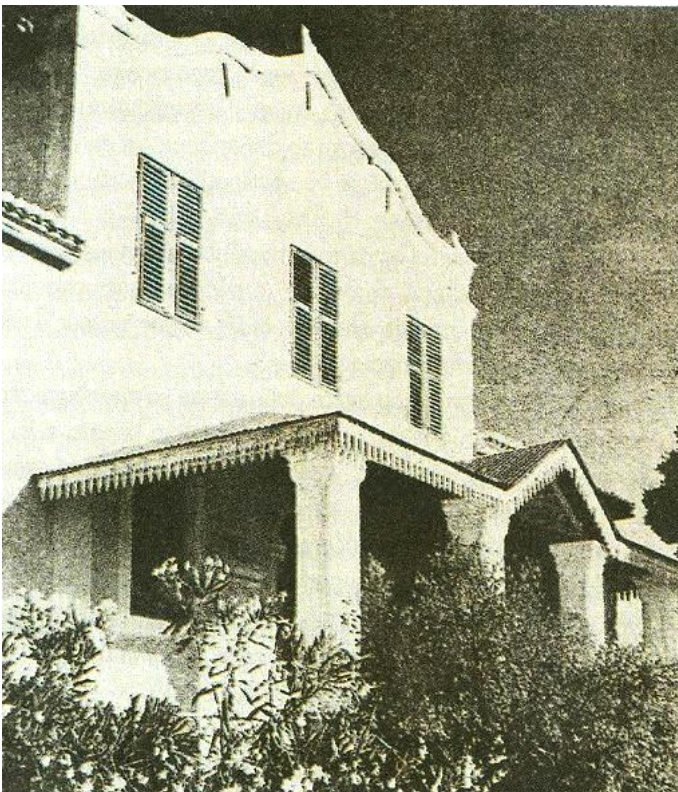
Το σπίτι του Σολωμού στη Ζάκυνθο, πριν καταστραφεί εντελώς από τους σεισμούς του 1953
